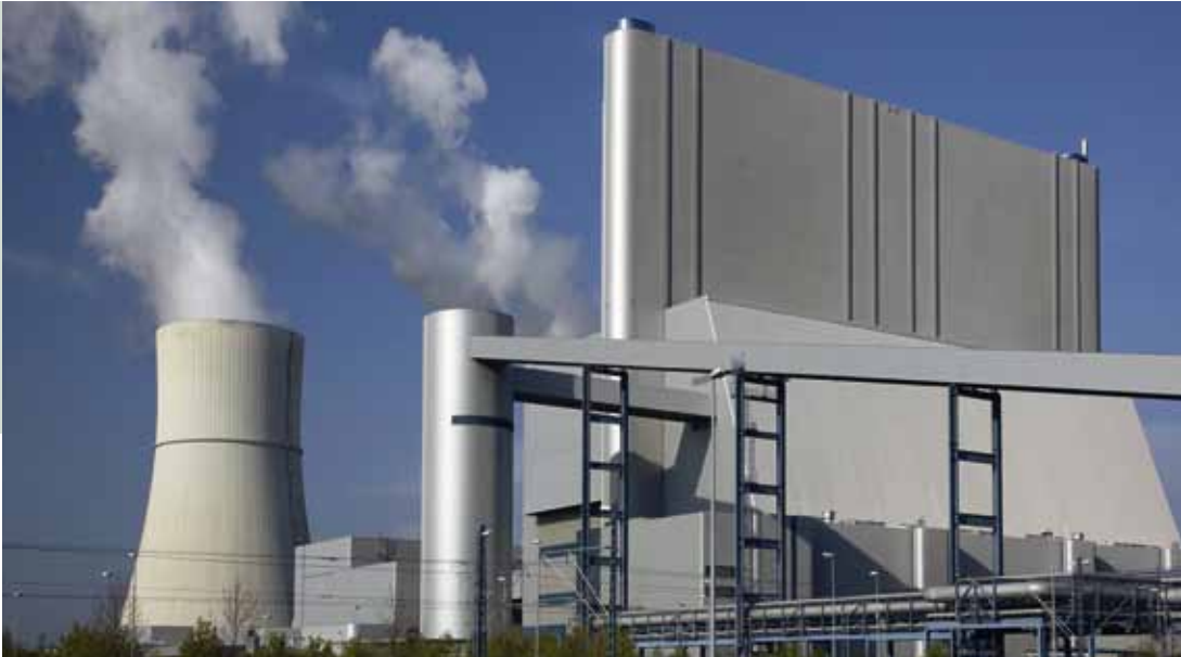
Kraftwerk Schwarze Pumpe – in Brandenburg betreibt Vattenfall Europe eines der modernsten Braun- kohlekraftwerke Europas.
